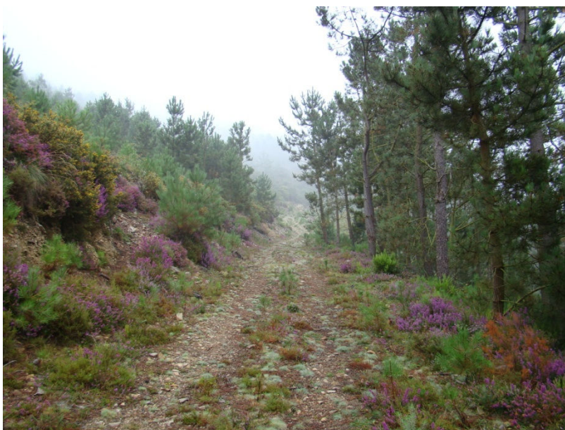
FOTO C.2: Camino C. Vista estado actual de plataforma.
